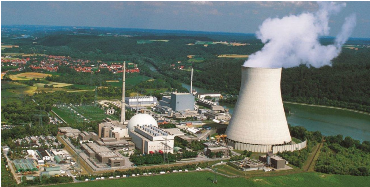
Abbildung 3: Ansicht des KKI 2, Blick aus westlicher Richtung
